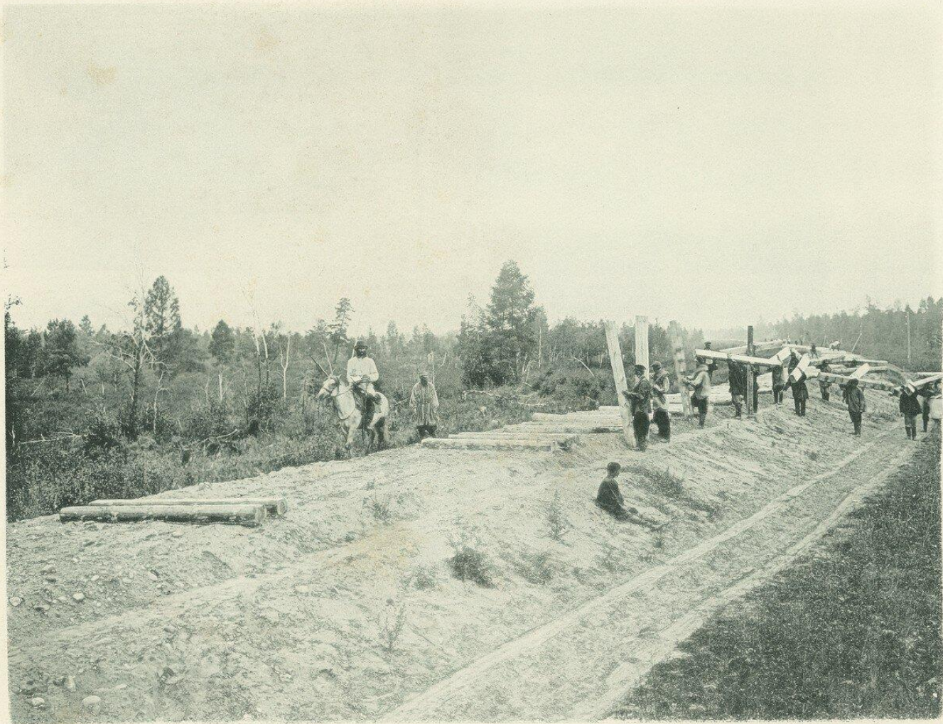
Укладна пути „Шпальщики“
